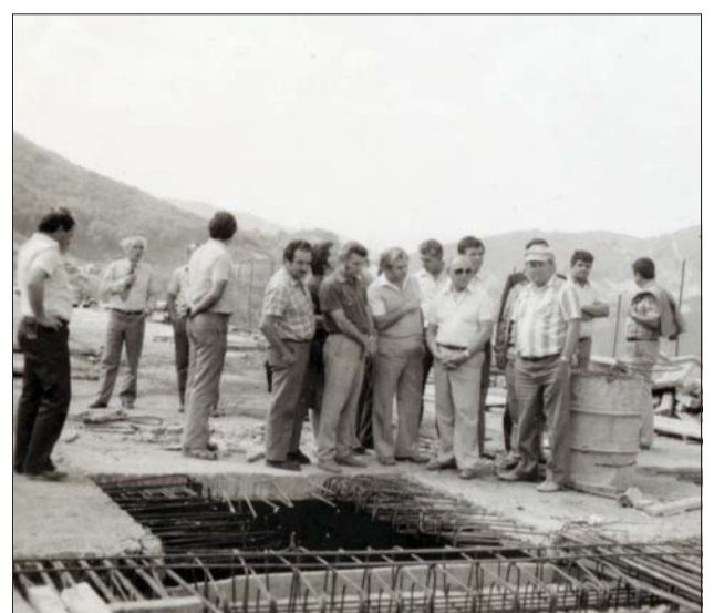
1985 г. - проверка на строителството на виадукт „Коренишки дол“
