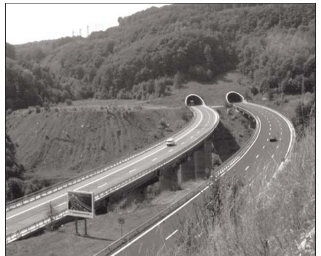
Виадуктът при 25-ия километър на магистралата, който е изграден в периода 1979-1985 г.
