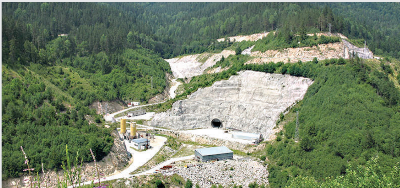
Строителната площадка на язовир „Яденица“
